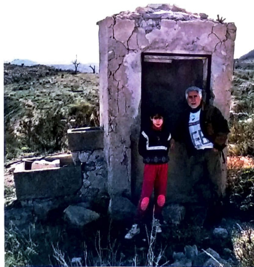
Foto 4. Aljibe en la zona de las canteras de las Cañadas, con cubierta semiesférica. Se aprecia la pileta a su izquierda.
